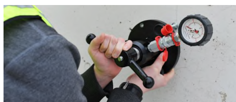
Ensayo en vertical en hormigón
