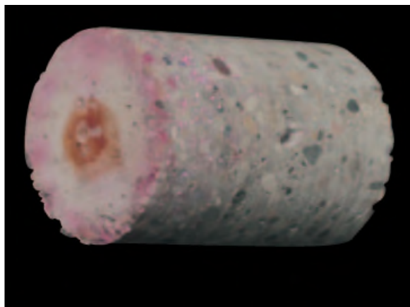
Un corazón de concreto que muestra el área no carbonatado de la izquierda
